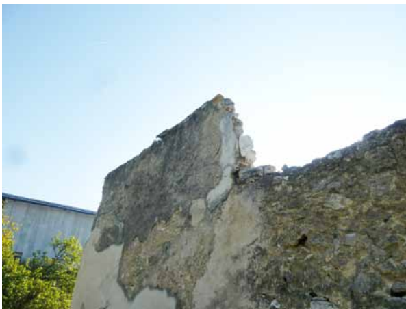
risque de chute de pierre voire d'effondrement
