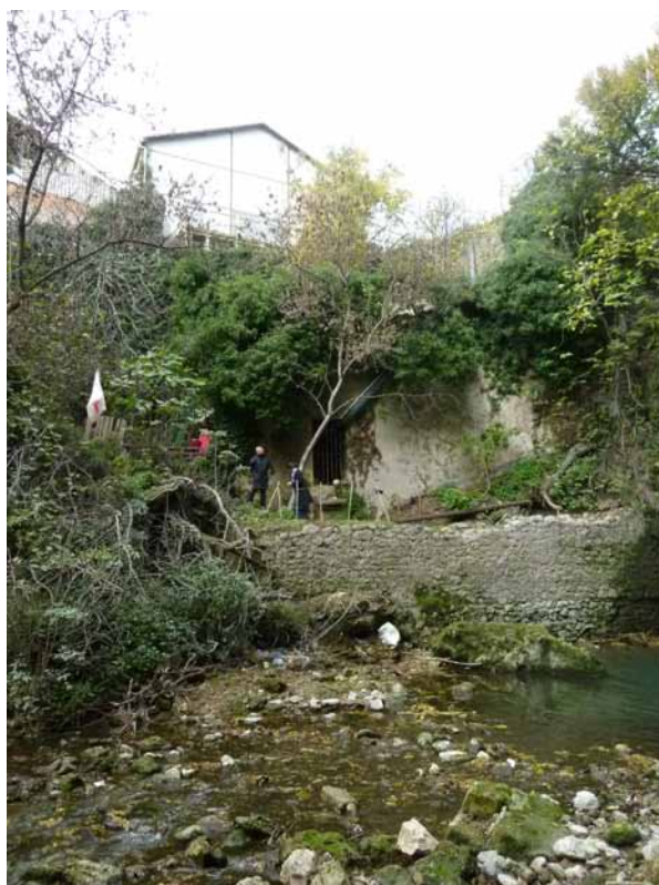
création d'un escalier et d'un gué de service pour l'entretien du ruisseau
