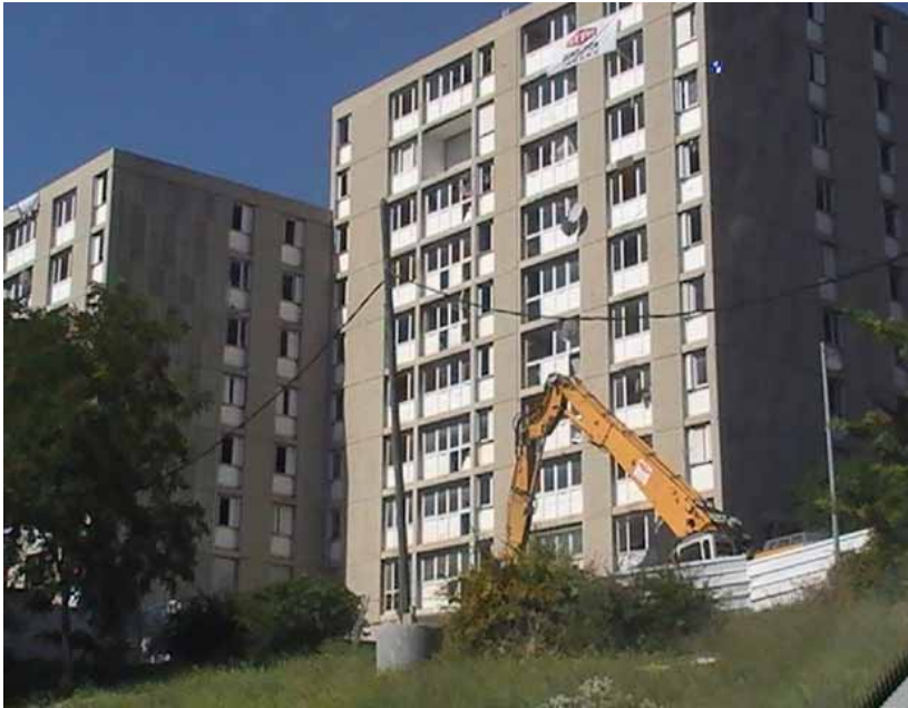
les immeubles des Créneaux, démolis en 2011
