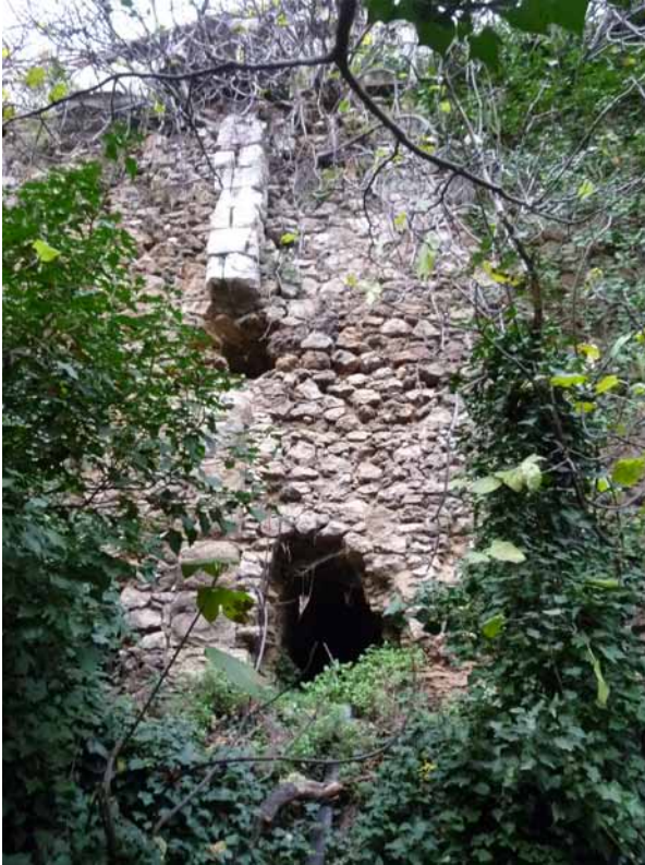
le mur de soutènement
