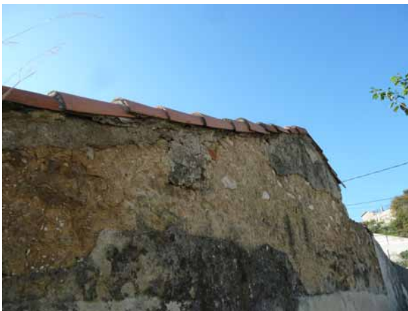
risque de chute des tuiles
