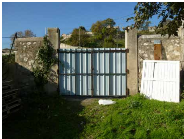
portail actuel, vu de l'intérieur du site
