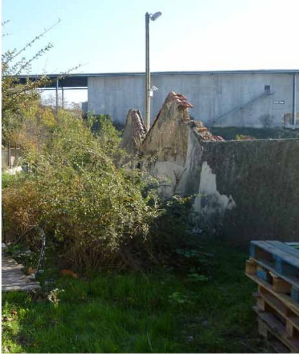
le mur mitoyen avec Santiard en mauvais état
