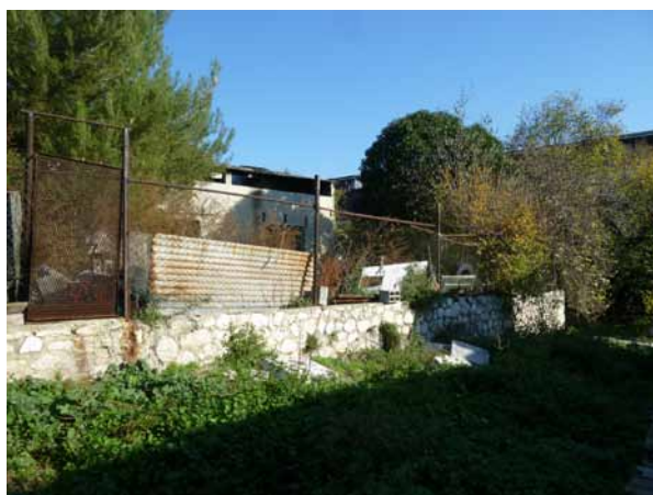
le mur mitoyen avec l'habitation est en bon état, il est par contre surmonté d'une clôture rouillée en mauvais état
