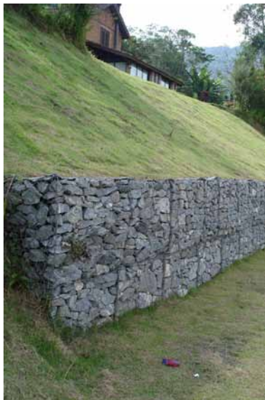
le gabion permet de créer facilement des terrasses dans la pente
